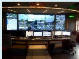
Realizzazione di una **sala radio** tra le più moderne d'Italia (di stampo autostradale) con Videowall composto da 18 Monitor con gestione remotizzata e grafo dinamico della rete con informazioni fornite dagli oltre 30 sistemi installati su strada (tempi di percorrenza, code, etc.) e con possibilità di monitorare contemporaneamente sino a 162 flussi video in parallelo.
